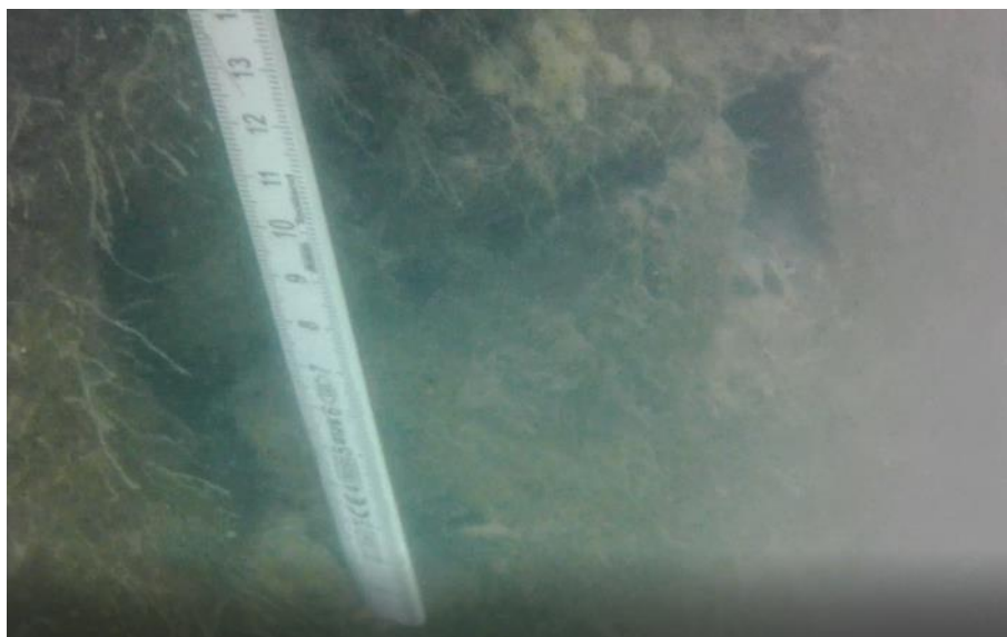
Figure 38 : Zone 3 Fissure en forme de Z
