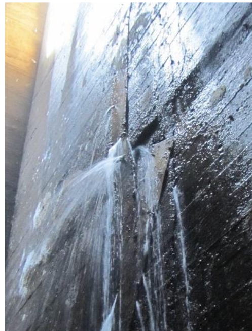
Figure 33 : Chômage de 2016 – Fuites sur la face aval de la chambre de retraite
