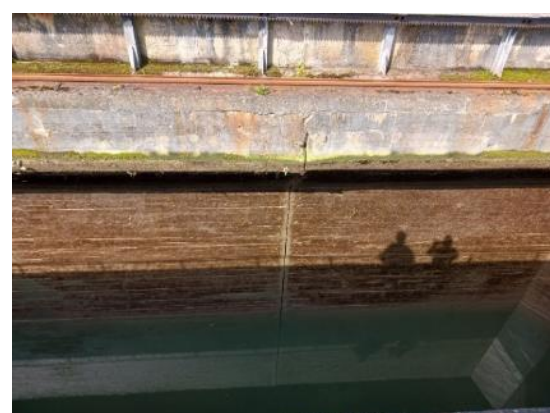
Figure 34 : Joint de la chambre de retraite de la porte aval, état en 2018 et en 2023
