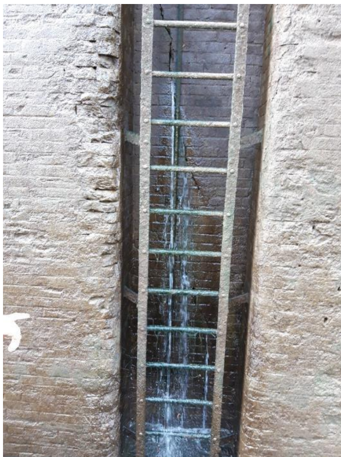
Figure 40 : Zone 3 : Venue d'eau par le passage de la première échelle rive gauche
