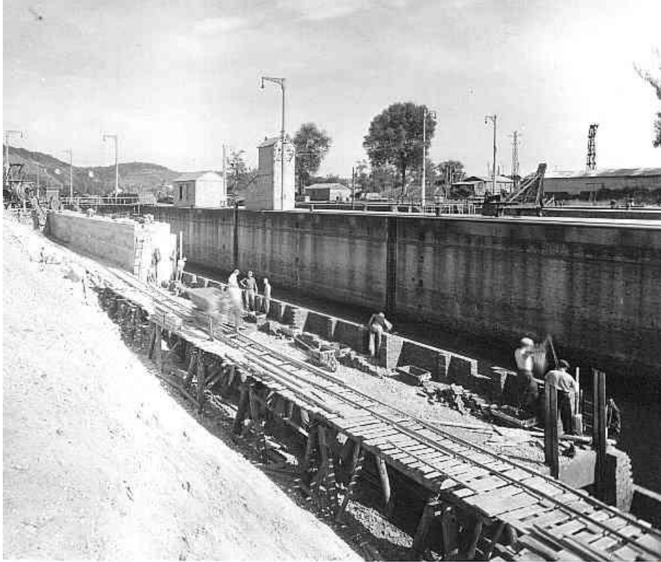
Bajoyer de terre - Briquetage du bloc 7 Joints cuivre des blocs 7 et 8
