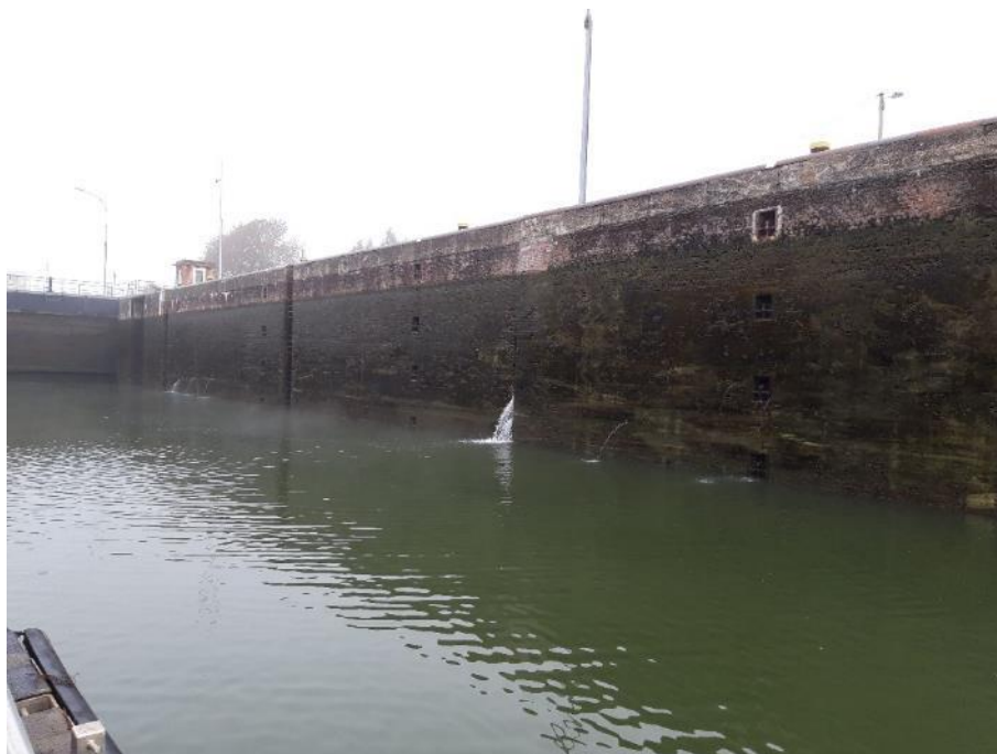
Figure 36 : Zone 3 : Venues d'eau par le second joint
