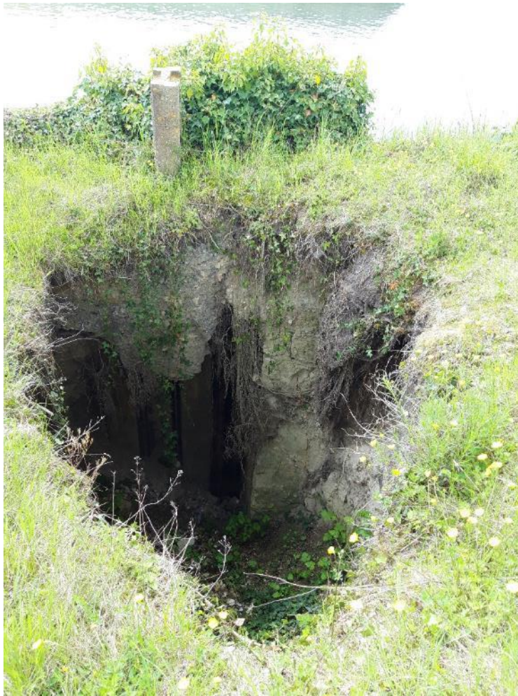
Figure 45 : Zone 5 Cavité visible en aval de l'écluse
