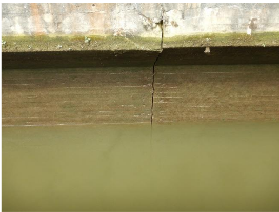
Figure 34 : Joint de la chambre de retraite de la porte aval, état en 2018 et en 2023
