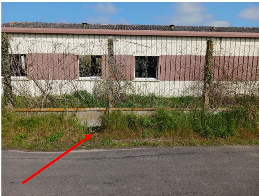
Figure 48 : Zone 6 : Flache et trous sous muret de clôture
