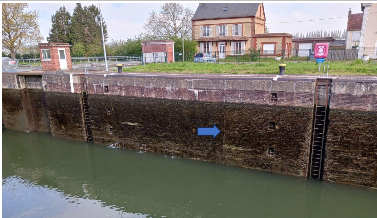
Figure 16 : Joint de fractionnement entre les plots 9 et 10 du bajoyer de terre.
