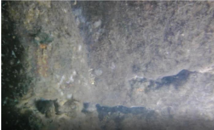
Figure 43 : Zone 4 : Mur aval rive droite – ouverture horizontale d'une palplanche
