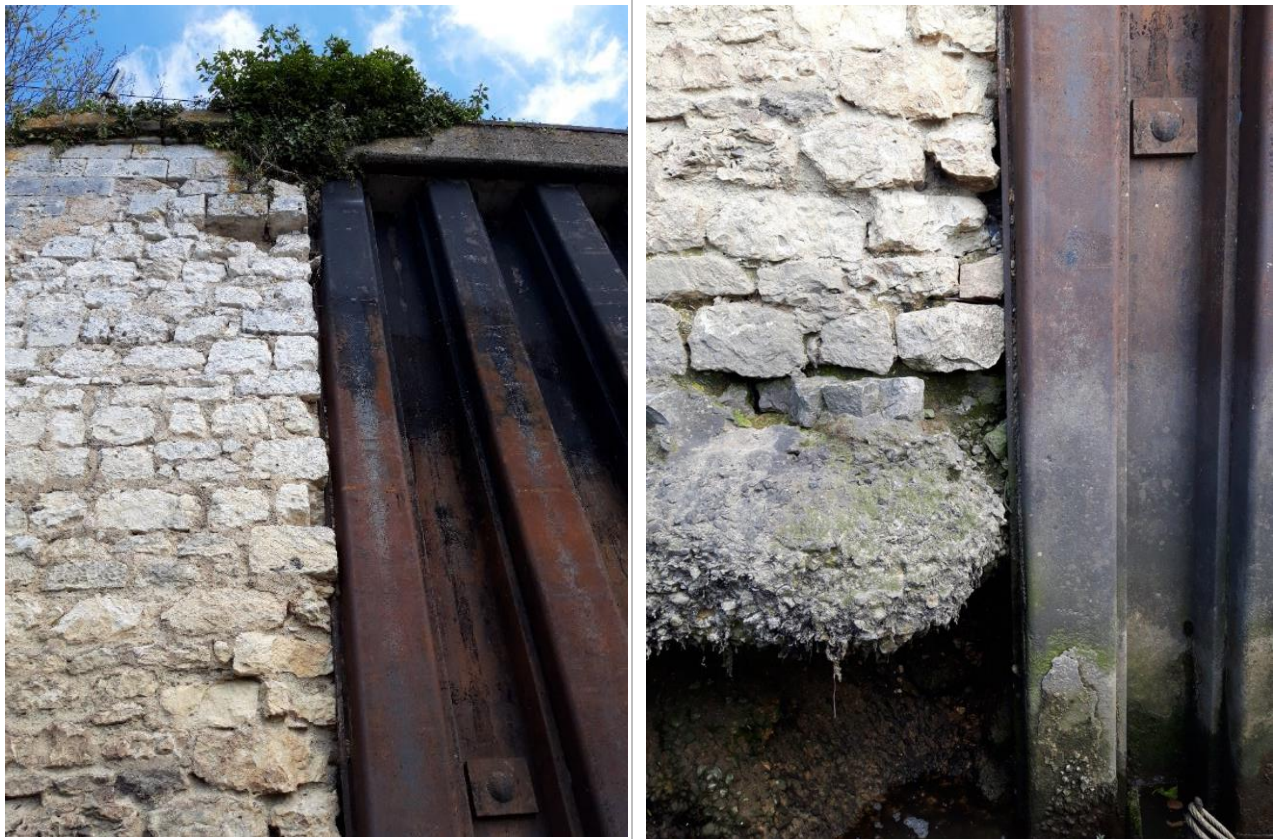
Figure 46 : Zone 5 Aval - Accostage palplanches / maçonnerie imparfait
