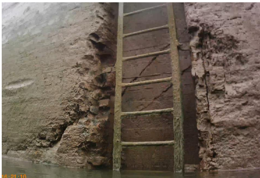
Figure 39 : Zone 3 : Fissure diagonale dans le passage de la première échelle aval rive droite
