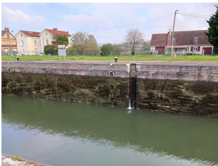
Figure 37 : Zone 3 : Venues d'eau par l'engravure de la troisième échelle
