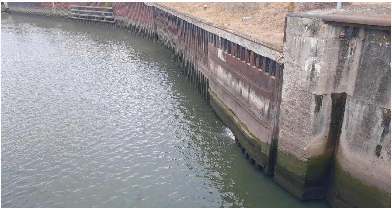
Figure 42 : Zone 4 : Rideau aval rive droite – venues d'eau visible à marée basse (photo VNF)
