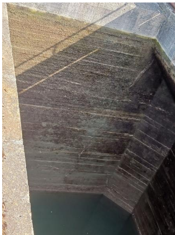
Figure 31 : Zone 2 : Chambre aval : joint de fond de chambre
