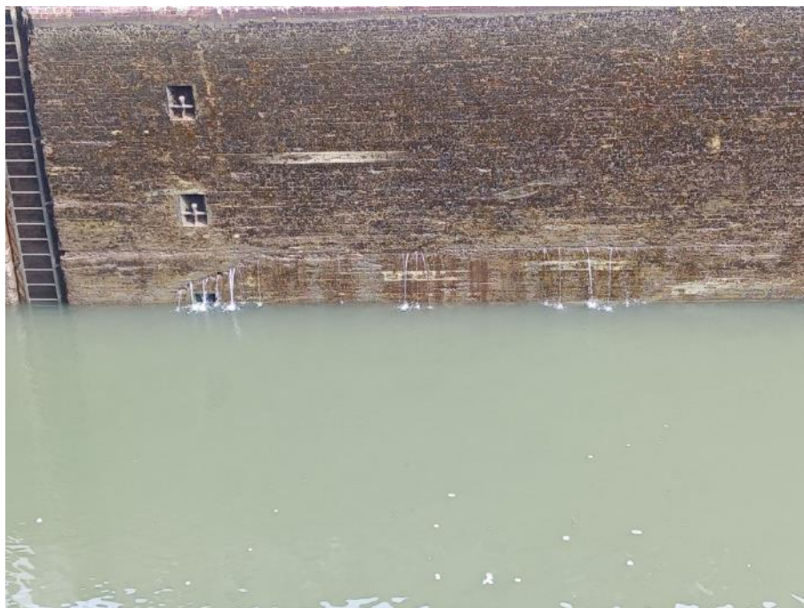
Figure 35 : Zone 3 - Venues d'eau en rive droite par la fissure horizontale
