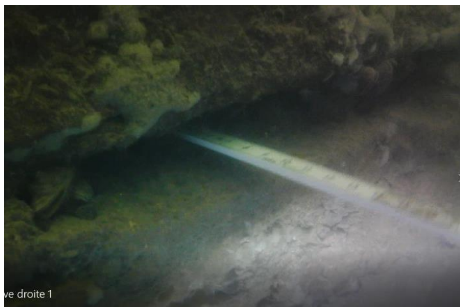
Figure 41 : Zone 3 - Cavité à la jonction bajoyer / radier
