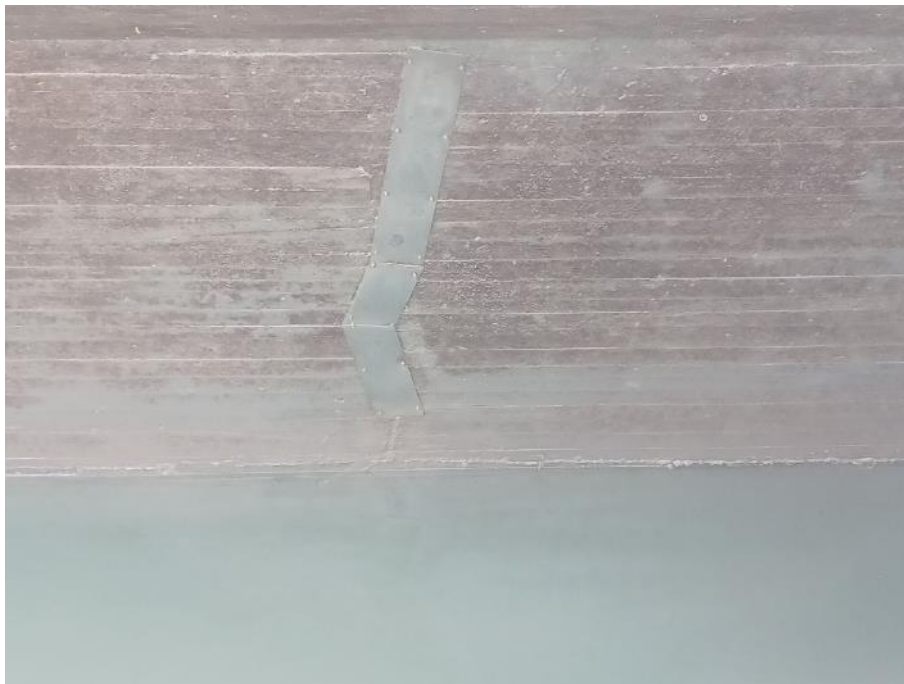
Figure 30 : Zone 2 : Capot visible sur un joint
