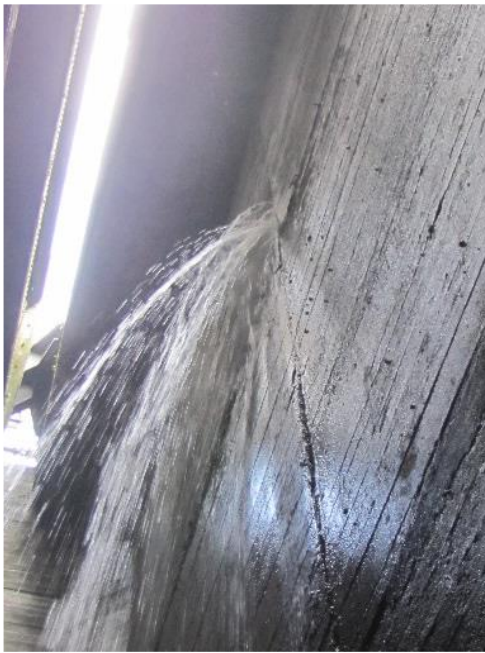
Figure 32 : Chômage de 2016 – Fuites sur la face amont de la chambre de retraite
